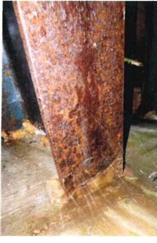
Absturzsicherung (Wanderweg), Korrosion Stahlträger, Wasserauskoklung Unterbau mit freiliegender Bewehrung
