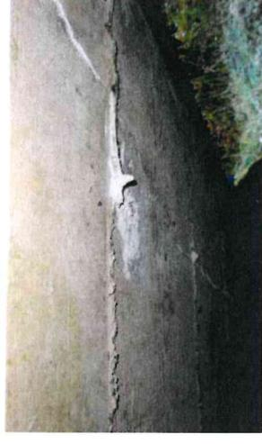
Betonabplatzungen mit freiliegender Bewehrung, Aussinterungen Überbau
