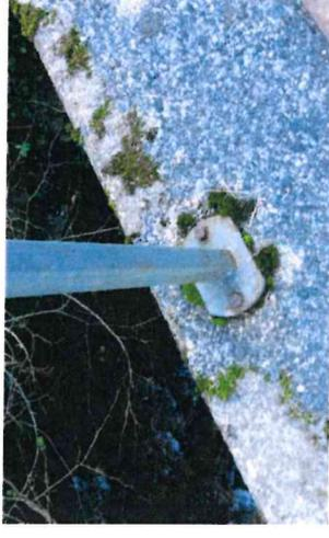
geschädigtes, zu niedriges Holmgeländer (falscher Typ) im Zuge Radnetz (Rinken), Höhe Oberstrom 75 cm, Fußpunkte keine Momentenübertragung möglich, Belagsschäden
