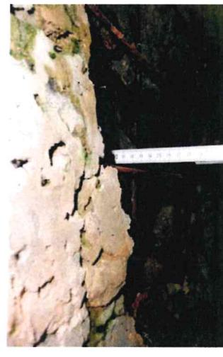
Betonausbrüche, freiliegende Tragbewehrung mit Querschnittsminderung, Absturzsicherung
