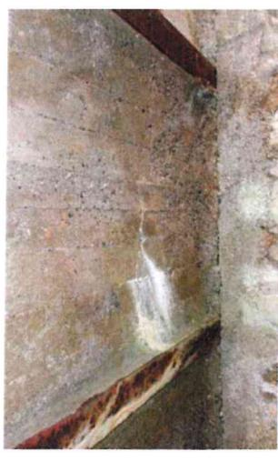
Längsrisse über Stahlträgern, Durchfeuchtung, Korrosion Stahlträger, Absturzsicherung fehlt (Wanderweg)
