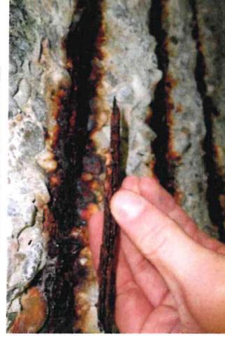
großflächig freiliegende Tragbewehrung mit Querschnittsminderung, Absturzsicherung
