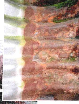
Absturzicherung fehlt, Korrosion Wellstahlrohr, Durchflussquerschnitt, Wasserauskoklung
